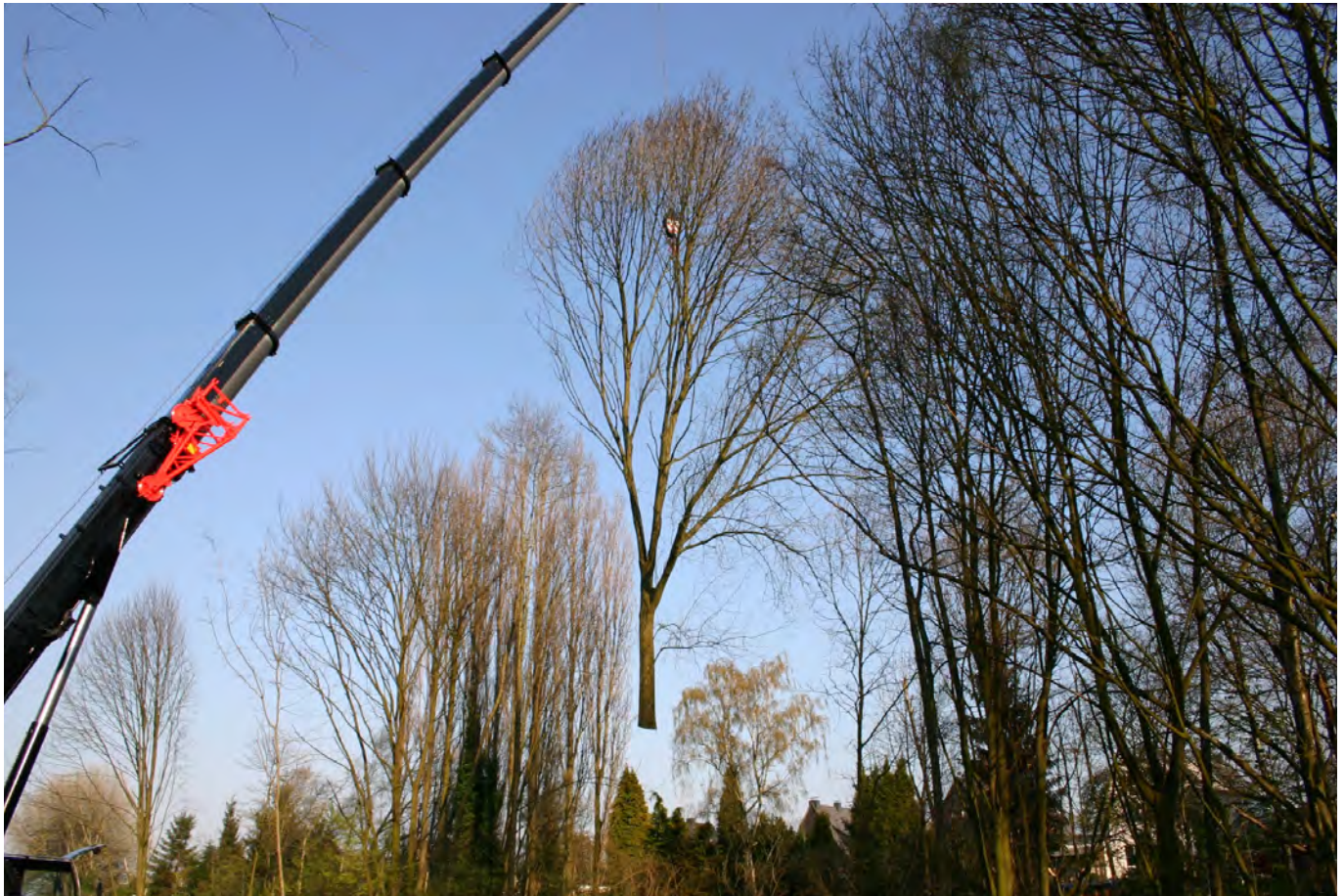
Fällarbeiten mit Kran und Kletterer an einer Bochumer Fernwärmeleitung
