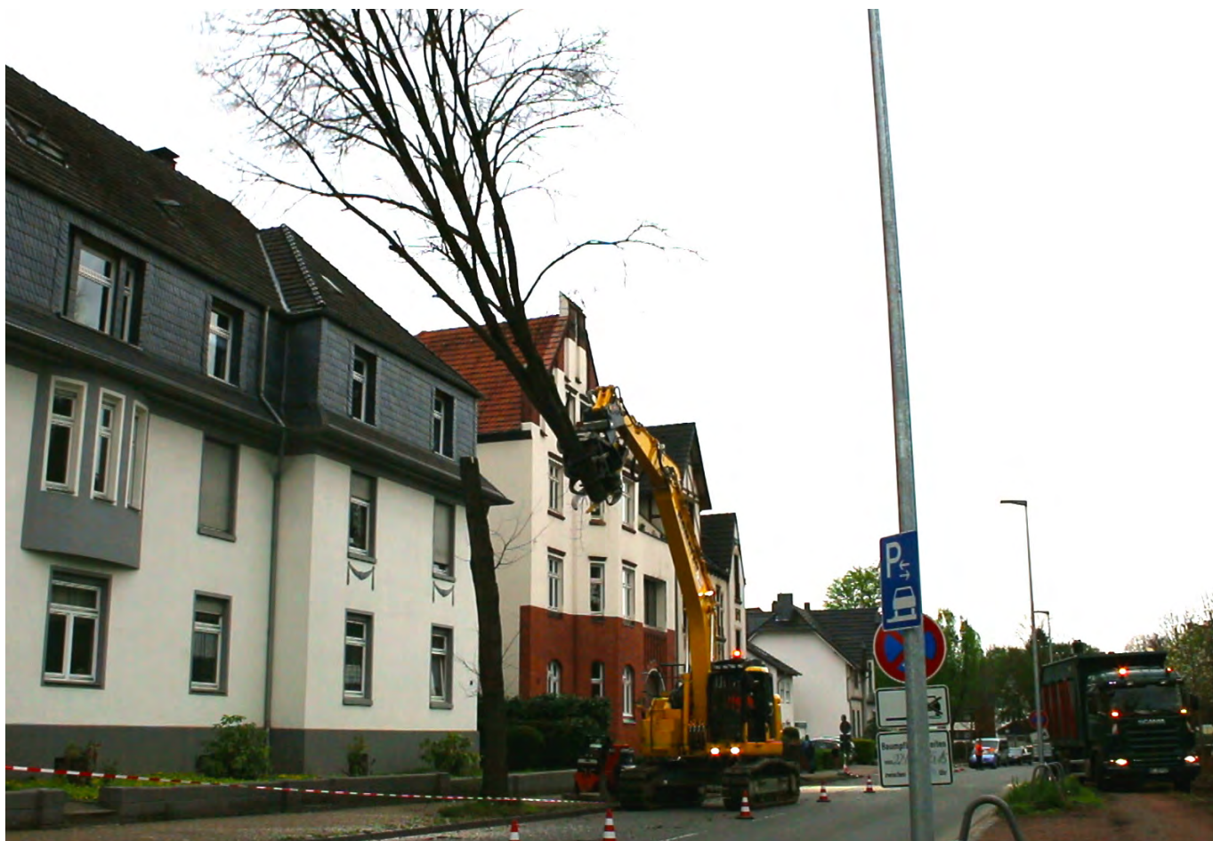
Kurzheckkraupenbagger auf Gummiketten mit Fällkopf
